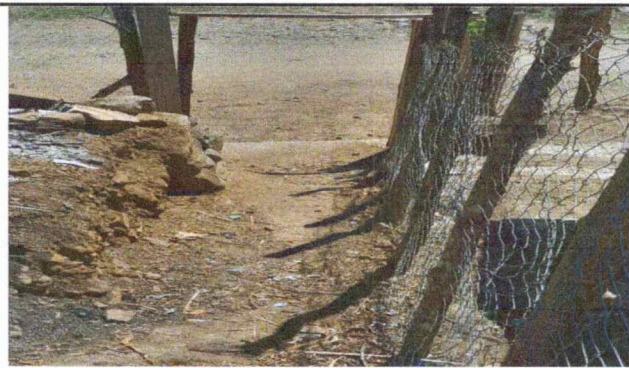
Foto 3: Pavimentación de la entrada principal.
